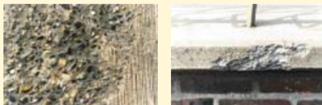
Figuur 6: Enkele voorbeelden van vorstdooizoutschade in Nederland door slechte nabehandeling (a) en lage kwaliteit (b)
