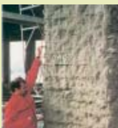
Electrochemische chloride-extractie van kolommen met gespoten vezelpulp; links met opgedrukte stroom (anode is een wapeningsnet), rechts met galvanische anodes; bron Raharinaivo, COST 521, 2002
