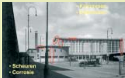
overzicht stationsgebouw en schadelocaties
