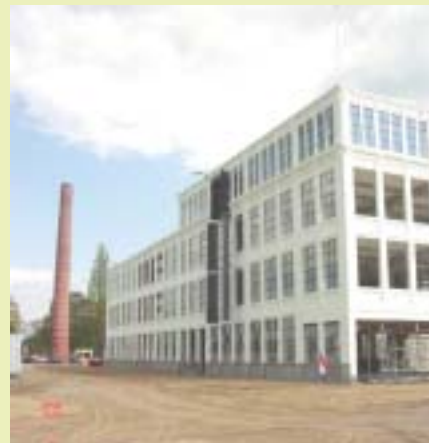
2004: Beschermende dampopen / carbonatieremmende coating op de gevel als compensatie te weinig betondekking
