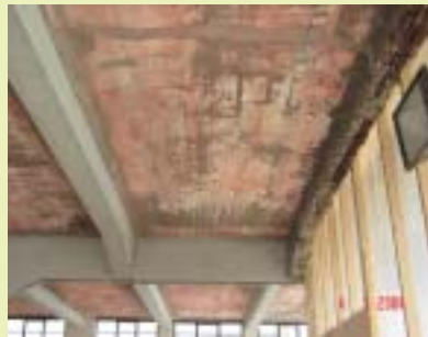
herstel dekking bestaande balken d.m.v. spuitbeton
