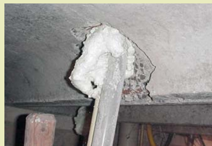
Kweekvloer, mechanische schade type A
