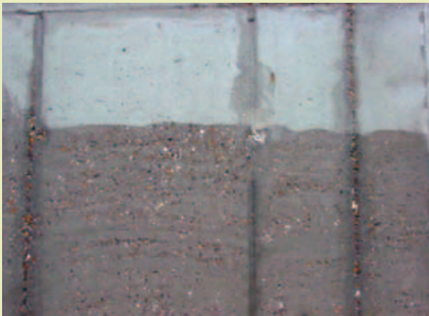
Grensvlak wel niet verwijderde cementhuid
