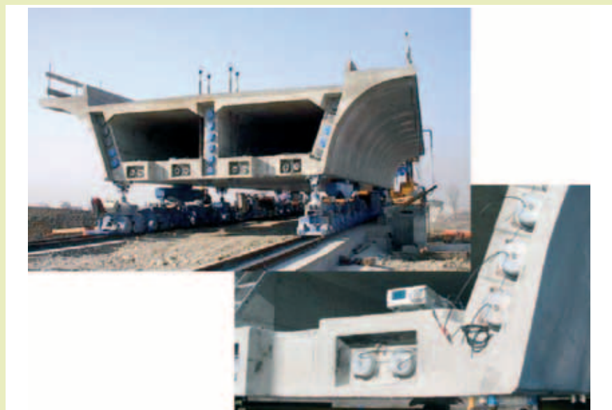
Figuur 5 Aanzicht prefab spoorbrugliggers en detail van meetkabels en -instrument
