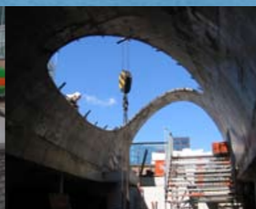
Voorbereiding plaatsing vensterframe
